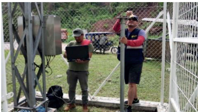
Mantenimiento estaciones automáticas Limpieza de tarjeta y configuración de trama de nivel de caudal estación EHA-Huayabamba (DZ09)
