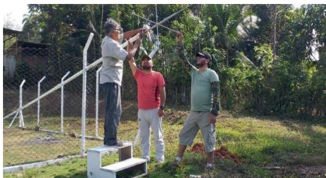
Mantenimiento acoplamiento de la veleta anemométrica CO-Chazuta (DZ09)
