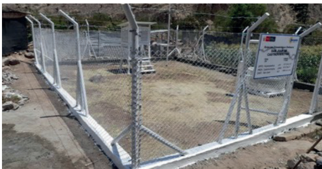
Vista final del cerco perimétrico Estación CO San Juan de Castrovirreyna (DZ05)
