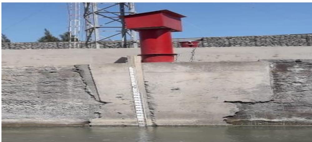
**Construcción de Muro instalación de regla limnimétrica y Tubo Limnigráfico**
