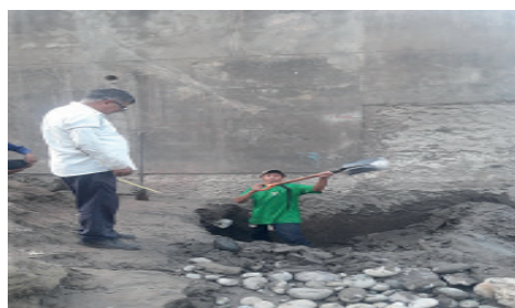
Excavación para la zapata de la columna de la estación 'Picota
