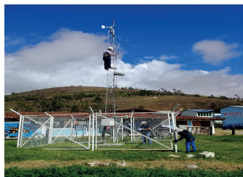
Personal de la DZ 3 realizando mantenimiento preventivo y correctivo de la CO- Celendín
