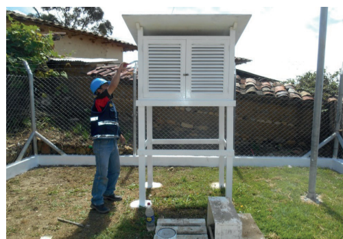
Personal de la DZ 3 realizando el mantenimiento preventivo de la caseta meteorológica en la estación PE-Cachachi.
