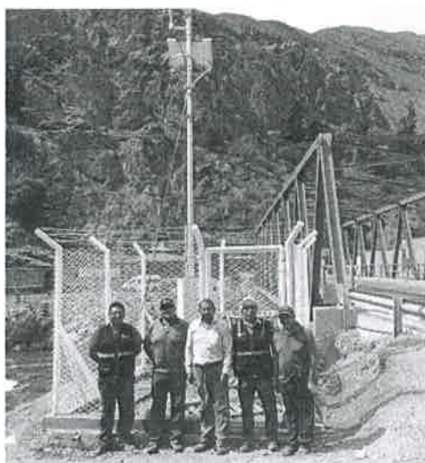
Rehabilitación de la estación hidrometeorológica automática Pacaran
