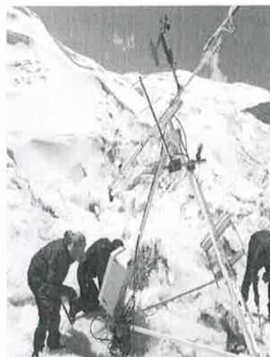
Rehabilitación de la estación hidrometeorológica automática Quisopiquina
