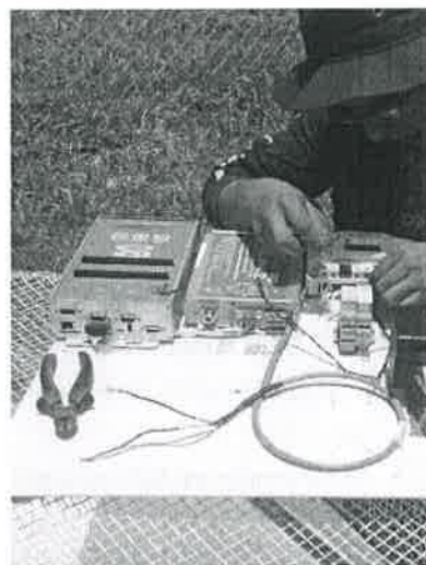
Rehabilitación de la estación hidrometeorológica automática Chavín
