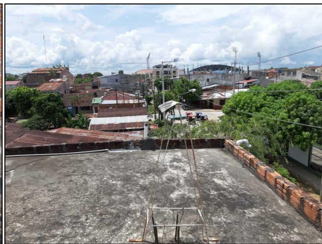
Foto 6: Estación Parque Zonal.
