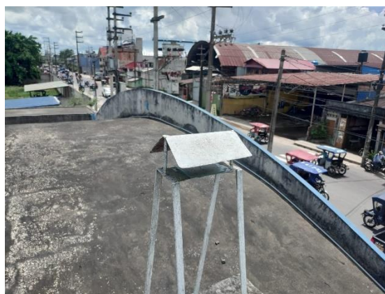
Foto 9: Estación Bomberos (Jr. Próspero)
