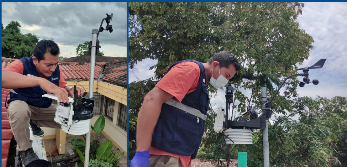
Mantenimiento de las estaciones automáticas Davis.
