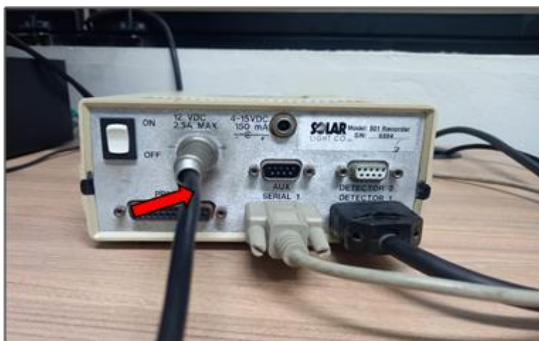
Figura N°9 – Conexión del cable de suministro de energía eléctrica al registrador
