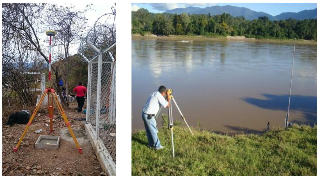
**Figura 5.5** Trabajos de monumentación de puntos geodésicos y nivelación del cero de la escala limnimétrica
