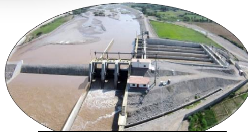
BOCATOMA LA ACHIRANA
