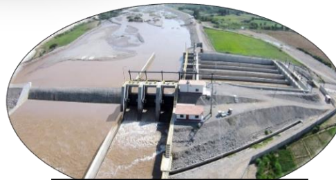
BOCATOMA LA ACHIRANA
