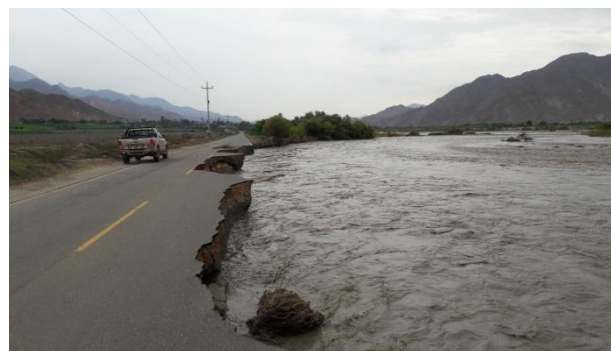
Fotografía 3. Carretera Paijan-Cascas, en la localidad de Pampas de Jaguey
